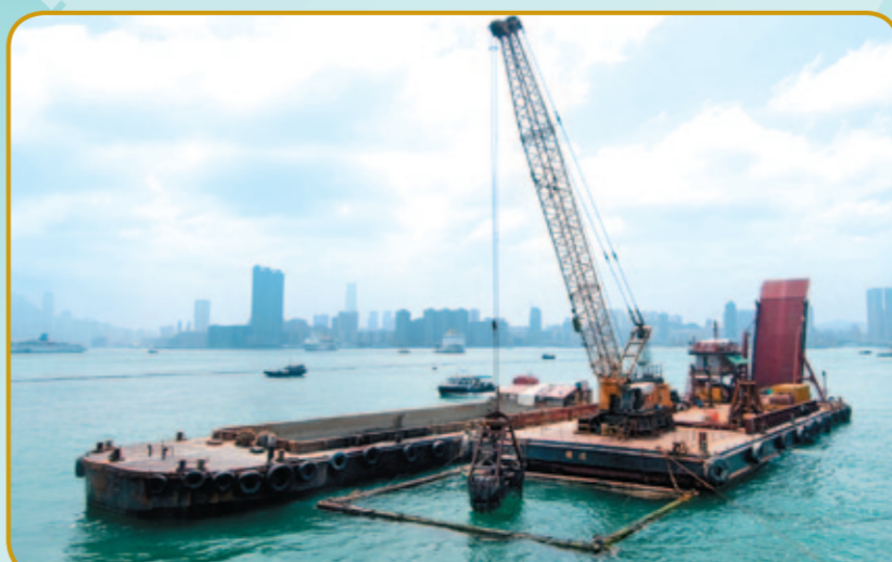
海底疏浚工程 Dredging of sea-bed
